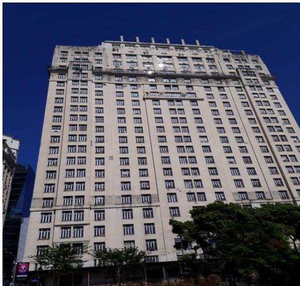
(Edifício Joseph Gire, conhecido como A Noite, era local da Rádio Nacional, considerado um arranha-céu na época. Foi inaugurado em 1927, projetado por Joseph Gire e Elisário Bahiana. Foto por Gabrielle Rosa.)
